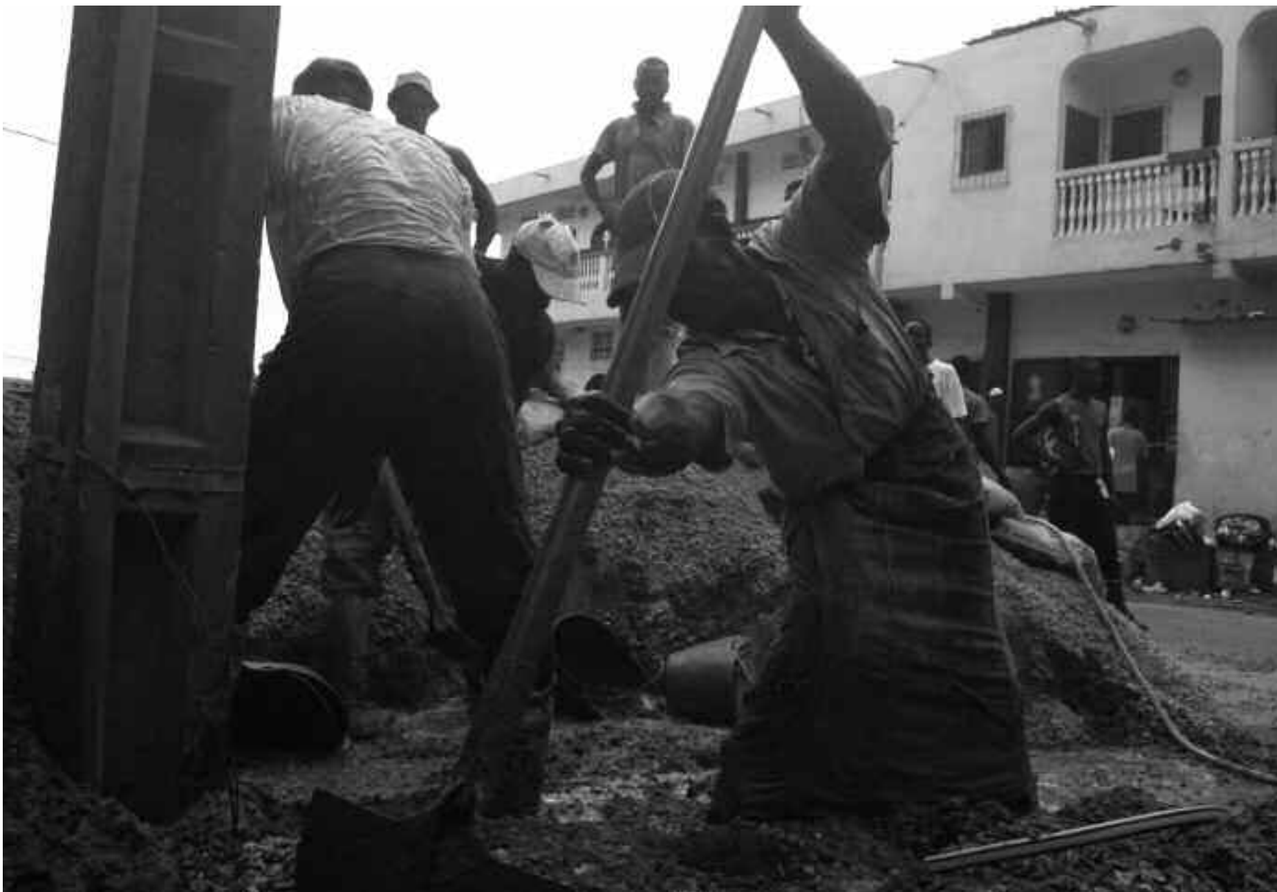
Bétonniers étalant le béton
