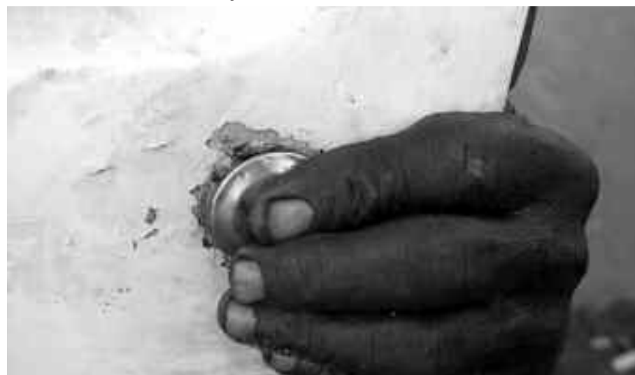
Tolier, reparation d'une serrure
