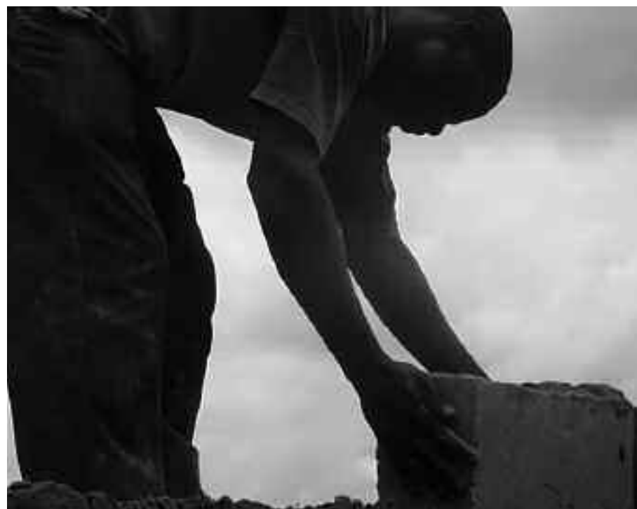
Construction d'un mur de maçon
